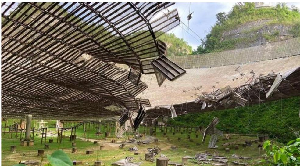
comunque stato demolito, dopo i due gravi incidenti di quest'anno che hanno reso inservibile la gigantesca antenna, larga 305 metri e formata da quasi 40 mila pannelli di alluminio montati su una rete di cavi d'acciaio; la più grande del mondo fino all'entrata in servizio, nel settembre 2016, del radiotelescopio [FAST da 500 metri](#), situato nella provincia di Guizhou in Cina.
